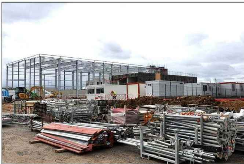
Le chantier d'Ecocea, l'usine de méthanisation, n'a aucun jour de retard pour le moment. Photo G.J.
