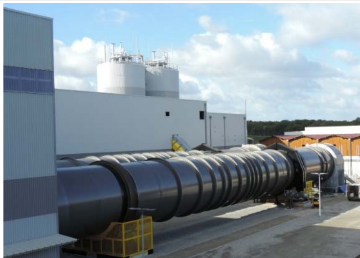
Vue générale de l'usine : au premier plan, les malaxeurs, à l'arrière plan, les digesteurs. ©Smet 71.
