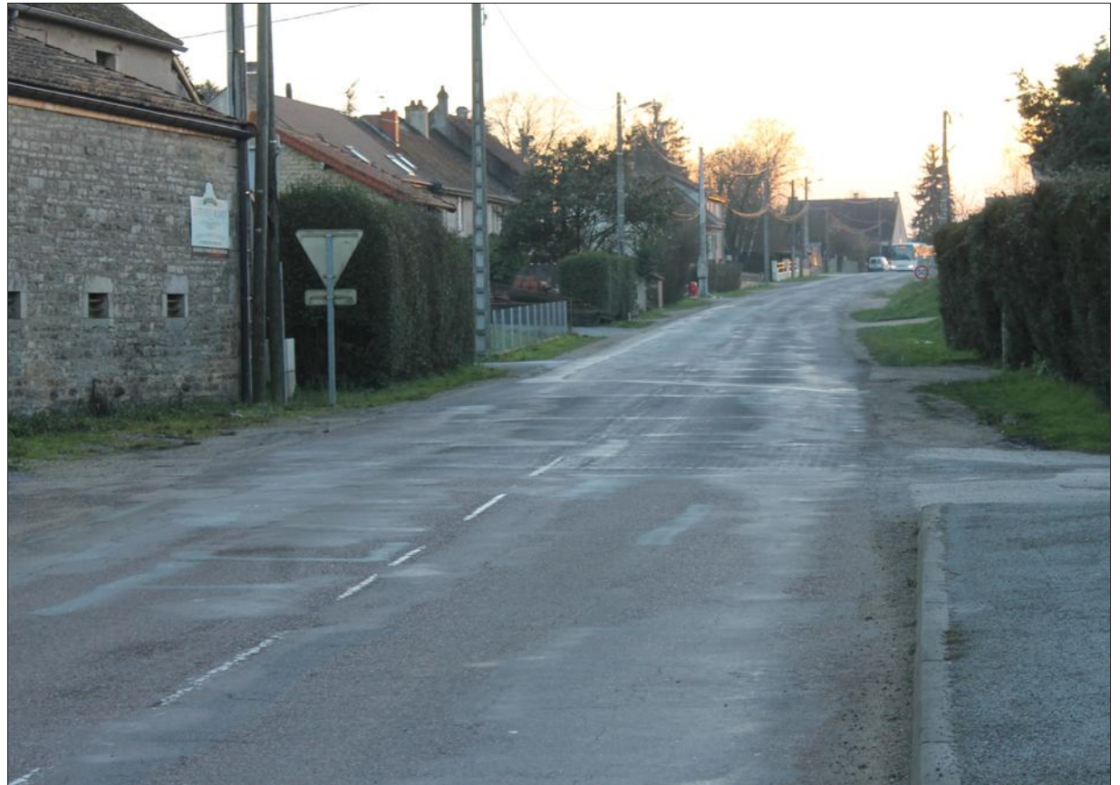
■ Les travaux de réfection débuteront au 4 e trimestre de cette année. Photo Geoffrey FLEURY
