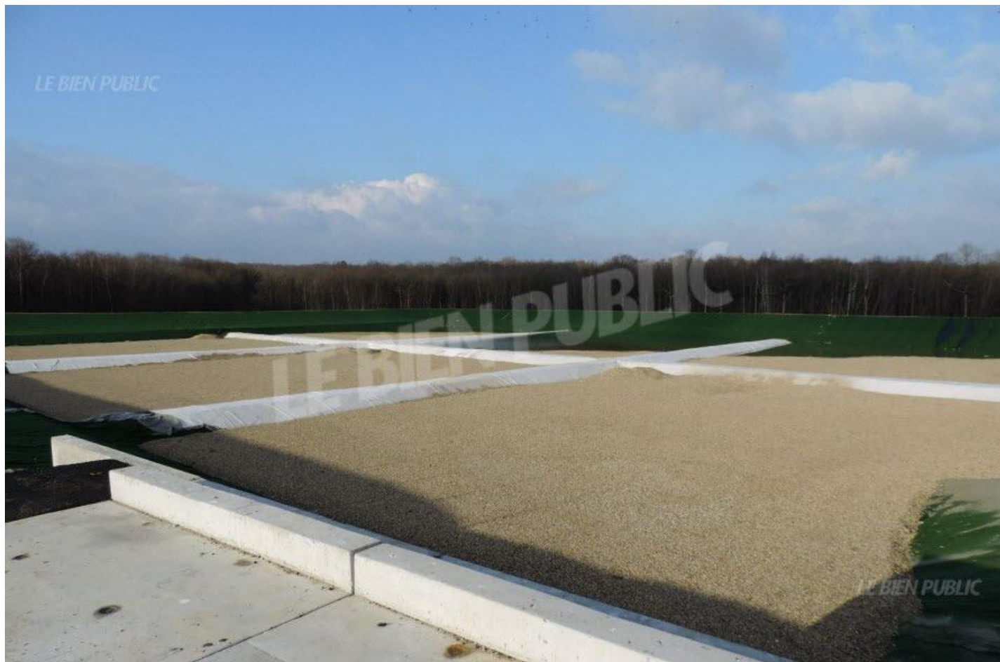
Le casier F, construit l'année dernière, entrera en service au 1 er semestre 2018. Son coût est d'environ 2,3 millions d'euros, pour une surface au fond de 18 500 m 2 compartimentée de six alvéoles de 2 000 m 2 . Il devrait être plein en 2021. Photo Grégory JACOB ( JSL)
