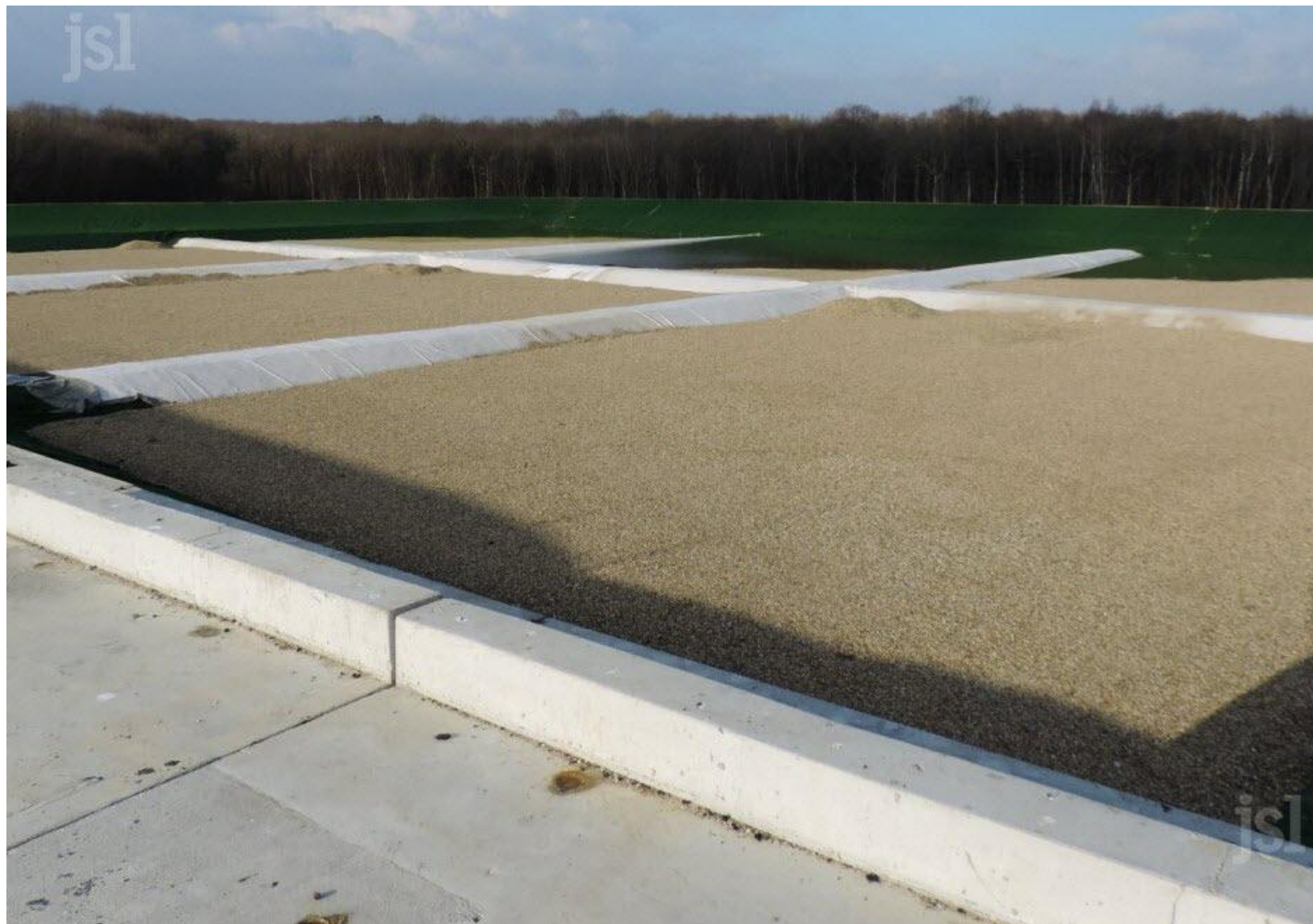
Le casier F, construit en 2017, entrera en service au 1 er semestre 2018. Son coût est d'environ 2,3 millions pour une surface au fond de 18 500 m 2 , compartimenté de six alvéoles de 2 000 m 2 . Il devrait être plein en 2021. Photo Grégory JACOB
