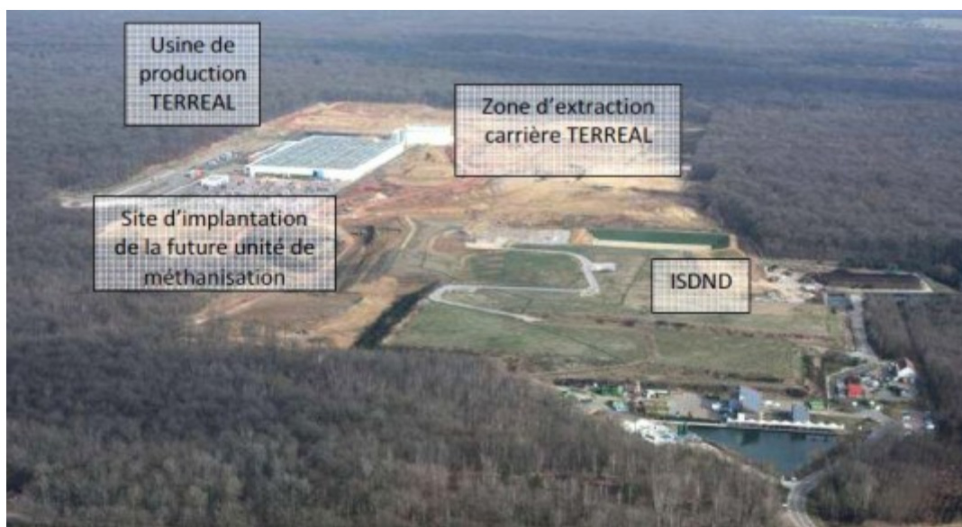
Vue aérienne du projet Ecocéa et localisations
