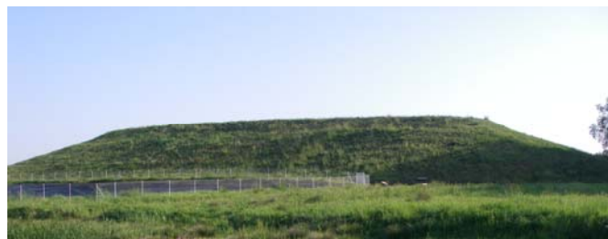
Centre d'enfouissement de Branges, fermé depuis 2003.
